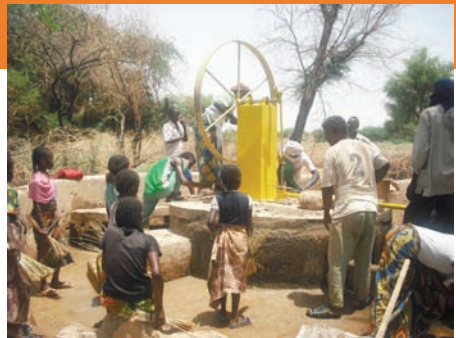
Les hommes, les femmes et les enfants se pressent autour du puits communautaire nouvellement équipé d'une pompe à main Volanta avec filtre pour assainir l'eau à usage domestique (Indoudou 2010).
